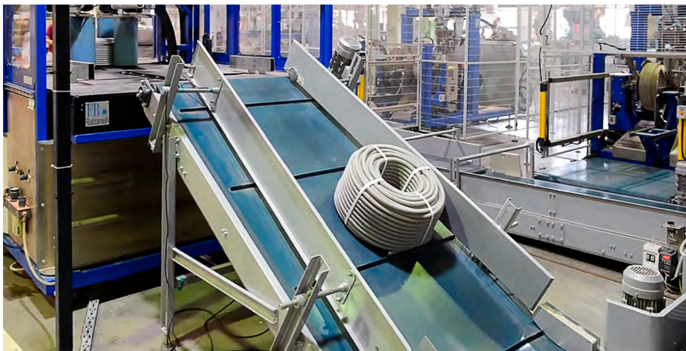
Линия по производству гофротруб IEK® на предприятии IEK GROUP
